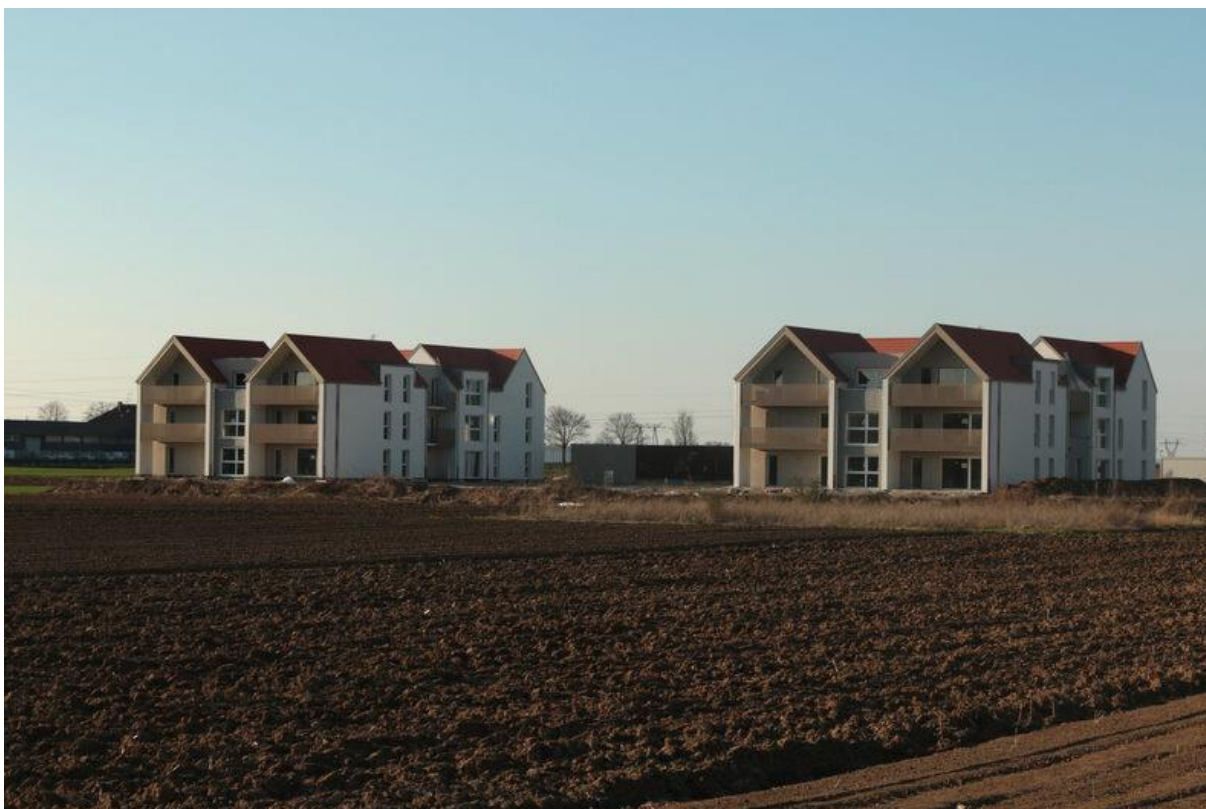
De nouveaux immeubles en construction, au bord des champs. Photo : Thibault Vetter / Rue89 Strasbourg
